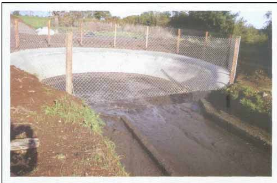
Figura 5. La impermeabilización de los pozos purineros es importante en la prevención de la infiltración en el suelo y contaminación de napas freáticas.
